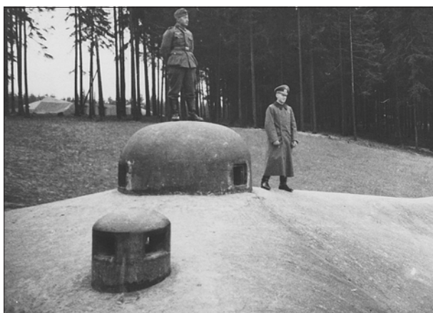
První ventilační zvony byly osazeny na objektech MO-S 40 a 42 na tvrzi Smolkov. Na fotografii je vidět nasávací ventilační zvon objektu MO-S 40. (1938, LT)
