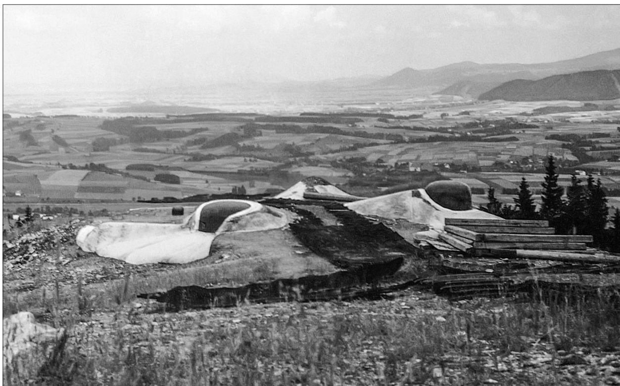
Vlevo je vidět jeden ze dvou osazených ventilačních zvonů malého typu na stropní desce pěchotního srubu K-S 23 tvrže Bouda. (1938, LT)
