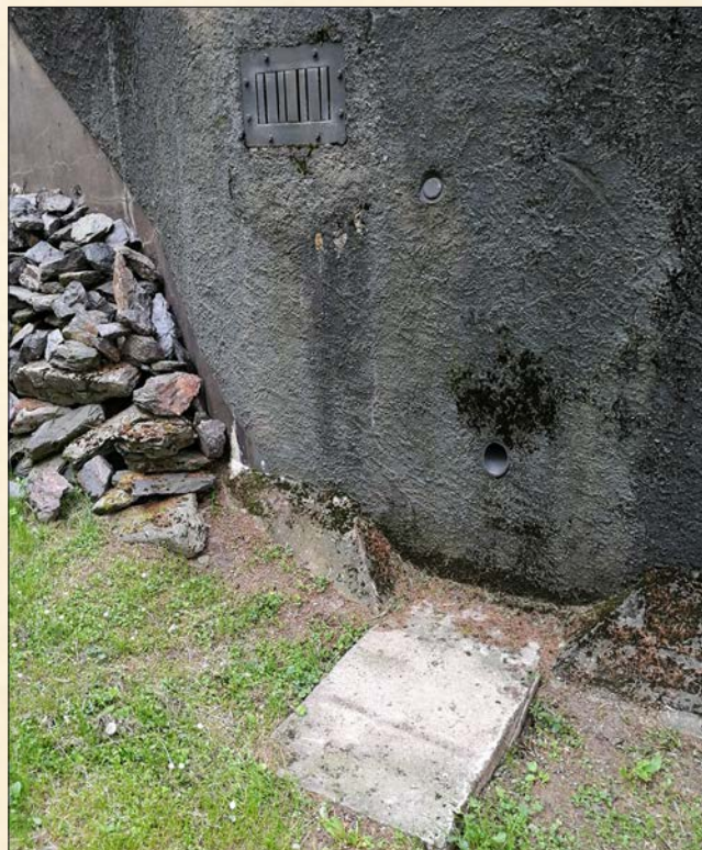
Granátovým skluzem byl chráněn i otvor pro nasávání vzduchu v pěchotním sruhu N-S 48 tvrže Skutina umístěný u paty záhozu zadní stěny. Ani zde nechybí otvor pro periskop. (2018, LČ)
