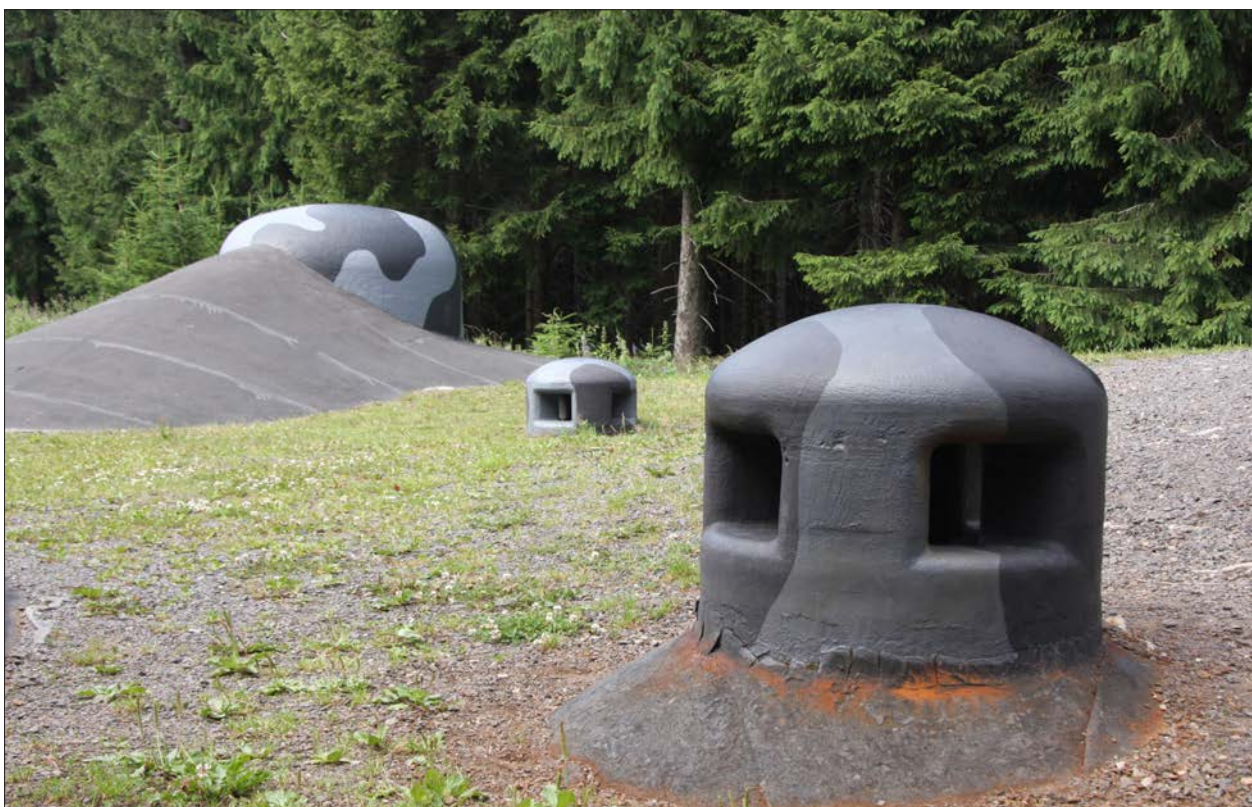
Dvojice zachovalých ventilačních zvonů středního typu na střeše objektu R-S 78 tvrže Hanička určeného pro osazení dělostřelecké věže RO. (2016, LČ)
