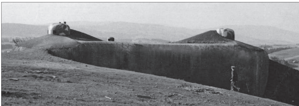
Pohled na střechu tvrzového pěchotního srubu K-S 13 tvrže Berghöhe (Hůrka). Mezi dvěma pěchotními zvony pro lehký kulomet je vidět nasávací ventilační zvon středního typu. (1938, LT)
