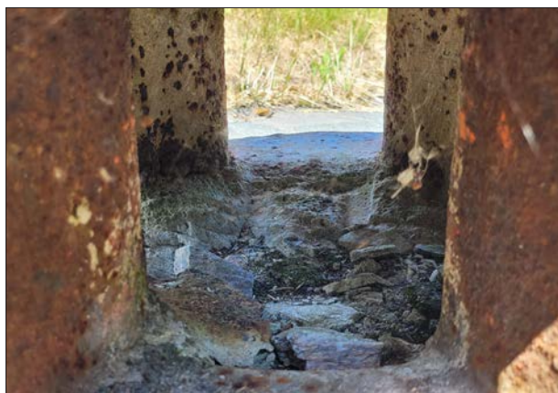
Pohled na zabetonované potrubí ventilačního zvonu na pěchotním sruhu R-S 80. (2023, LČ)
