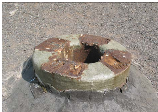
U druhého ventilačního zvonu na téže objektu byl odříznut celý vrchlík, aby tudy bylo možné snadněji svést kabely do objektu. (2003, LČ)
