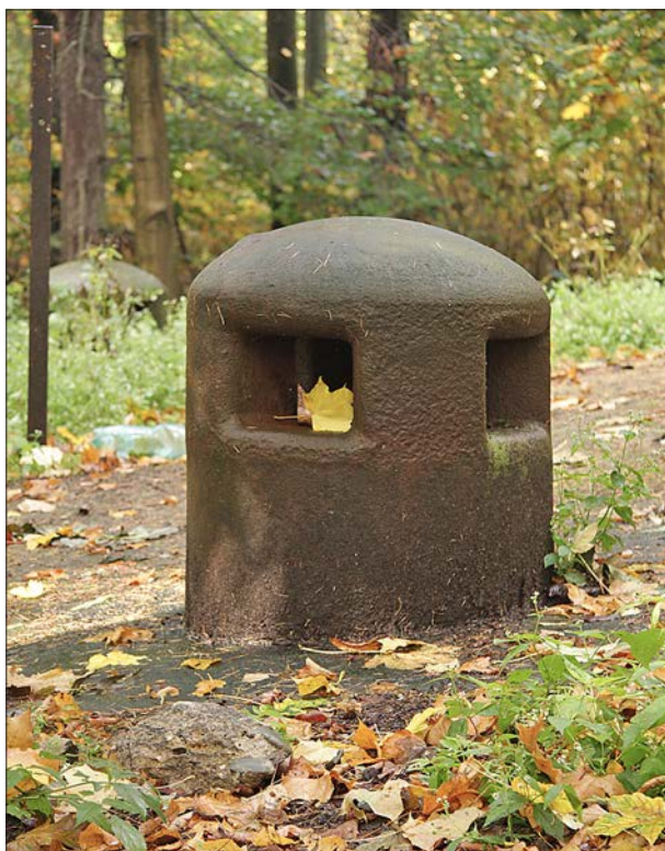
Ventilační zvon pro nasávání vzduchu na objektu MO-S 38 tvrže Smolkov. (2009, LČ)
