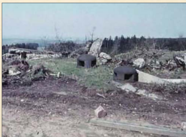
Vchodový objekt R-S 79a tvrze Hanička. Potrubí pro odtah výfukových plynů od motorů ve strojovně i zkaženého vzduchu z prostoru elektrárny byl zakončen ve dvou ventilačních zvonech na střeše objektu. (www.opevneni.cz)
