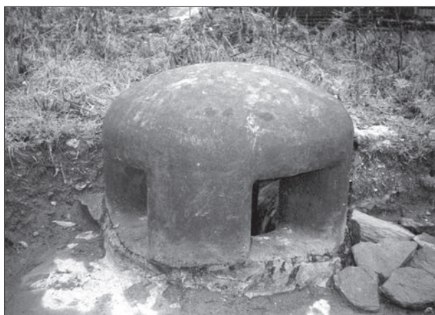
Jediný osazený a dochovaný ventilační zvon velkého typu na objektu R-S 79a na tvrzi Hanička. (JF)
