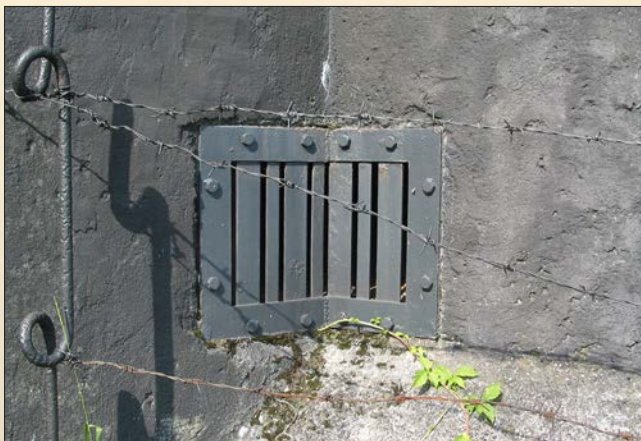
Otvor pro nasávání vzduchu v pěchotním sruhu T-S 73 tvrže Stachelberg byl umístěn velmi nízko nad terén, ale dosti nešikovně do místa zlomu stěny. Díky tomu by musela být krycí mřížka zalomená. (2003, LČ)
