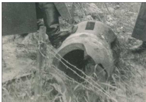
Poškozený ventilační zvon na dobové fotografii. (1940, LT)
