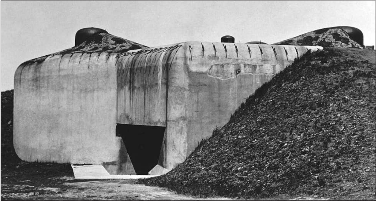
Pěchotní srub R-S 77 tvrže Hanička – na střeše objektu je vidět nasávací ventilační zvon. Vzhledem ke spádu a posunutí záhozu týlové stěny je zřejmé, že zde nebyl dostatečný prostor pro umístění nasávacího otvoru v zadní stěně. (1938, LČ)
