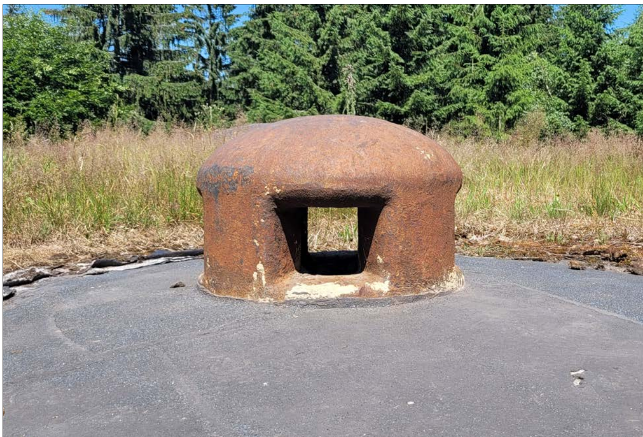
Jednoznačně nejzajímavější byly osudy ventilačních zvonů na objektech tvrze Hanička. Dobrým příkladem je ventilační zvon středního typu na pěchním srubu R-S 80, který byl za války poškozen, v 80. letech při úpravách objektu v rámci akce KAHAN byl zabetonován, zaizolován a zavezen zeminou a nakonec, v roce 2019, opětovně odhalen. (2023, LČ)
