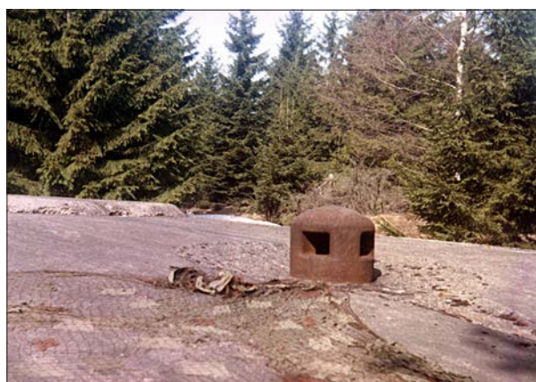
Ventilační zvony objektu K-S 42 pro dělostřeleckou věž na tvrzi Adam. Vlevo dobový snímek evakuačního zvonu (1938, LT), vpravo nahoře je sací zvon s průřezem ve vrchlíku (1992, TS) stejně jako na dolní fotografii, kde je vidět i maskovací síť, která byla začátkem 90. let minulého století rozprostřena na střeše objektu (AH).
