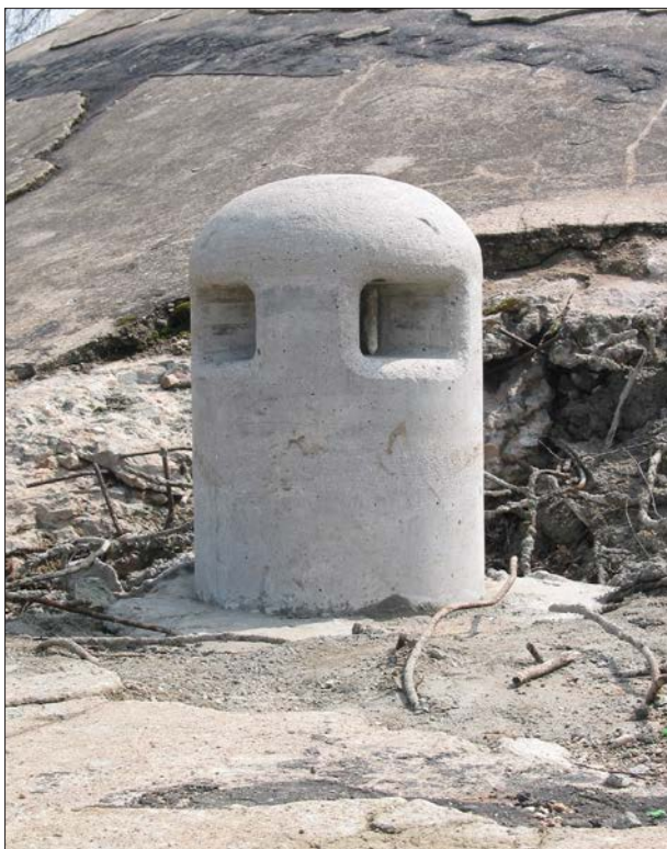
Mnohem lépe vypadá betonová maketa ventilačního zvonu malého typu na pozorovatelně K-S 12b tvrže Hůrka. (2004, LČ)
