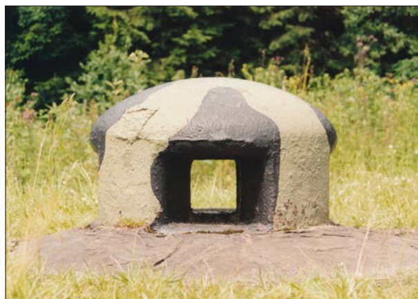
Střední typ ventilačního zvonu zachovalý na stropě pěchotního srubu R-S 76 tvrže Hanička. (2009, LČ)
