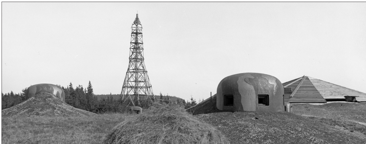
Fotografie zachycující všechny osazené pancéřové prvky na střeše objektu R-S 78 pro dělostřeleckou věž tvrže Hanička – evakuační ventilační zvon je přímo pod trigonometrickou věží, sací zvon vyčnívá napravo za pěchotním zvonem. (MPH)
