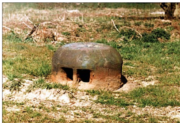
Německý ventilační zvon na jednom z objektů Meziříčího opevněného rajónu v Polsku. (1997, LČ)
