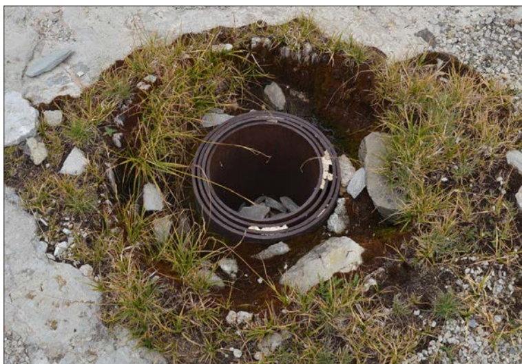
Pohled na přívodní potrubí bez osazeného ventilačního zvonu na objektu B3 tvrze Plan Caval. Dobře jsou vidět čtyři do sebe zasunuté trubky. (2022, MP)
