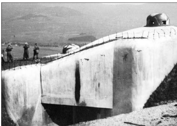
Jediná známá dobová fotografie pozorovatelny K-S 12b, na které je vidět sací ventilační zvon. (1938, MR)
