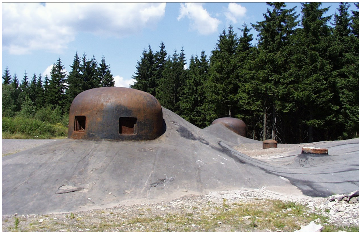
Pohled na všechny osazené pancéřové prvky objektu R-S 78 tvrze Hanička po odstranění betonové nástavby a zemní navázky. Vrchlík sacího ventilačního zvonu je odříznutý, otvory evakuačního zvonu jsou naopak zavařeny. (1999, BS)
