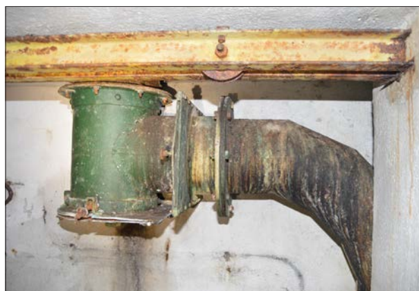
Pic de Garuche, objekt B2. (2015, MP)
