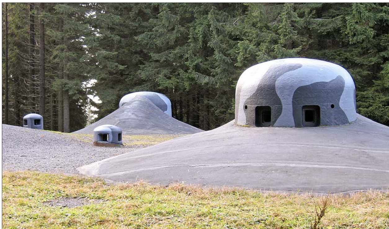
Porovnání velikosti pancéřových prvků na střeše objektu R-S 78 pro dělostřeleckou věž na tvrzi Hanička – vlevo dvojice ventilačních zvonů, vpravo kopule pro těžký kulomet a vzadu zvon pro lehký kulomet (vpředu). (2012, MPH)
