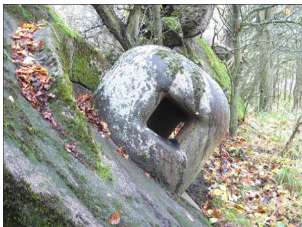
Ventilační zvon typu 409P9 na poničeném objektu Pz.W. 722 tvrže York, MRU Polsko. (PS)
