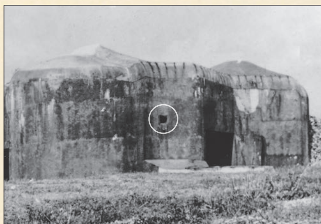
Otvor pro nasávání vzduchu ve stěně pěchotního sruhu N-S 73 tvrže Dobrošov byl naopak ve výšce téměř tří metrů nad terénem – vlevo detail oplechování vnější části sacího kanálu, vpravo pohled na umístění otvoru na dobové fotografii objektu N-S 73. (2003, LČ)
