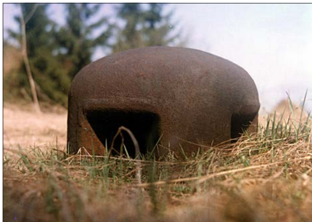
Jediný zachovalý ventilační zvon malého typu na střeše pěchotního srubu K-S 41 tvrže Adam. (AH)
