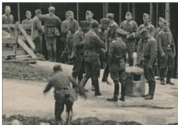
Ventilační zvon objektu MO-S 38 pro dělostřeleckou věž tvrze Smolkov. (LT)
