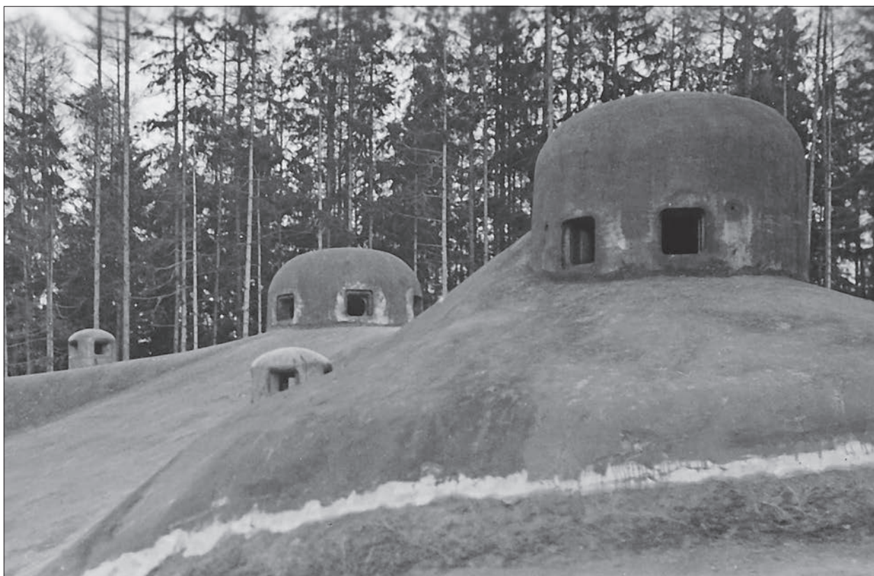
Pancěrové prvky na střeše pěchotního srubu MO-S 40 tvrže Smolkov. Vlevo jsou dva ventilační zvony středního typu, uprostřed zvon pro lehký kulomet a vpravo kopule pro těžký kulomet (na snímku chybí ještě druhá kopule a pozorovací zvon). (1938, LT)
