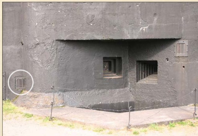
Otvor pro nasávání vzduchu v pěchotním sruhu T-S 73 tvrže Stachelberg byl umístěn velmi nízko nad terén, ale dosti nešikovně do místa zlomu stěny. Díky tomu by musela být krycí mřížka zalomená. (2003, LČ)
