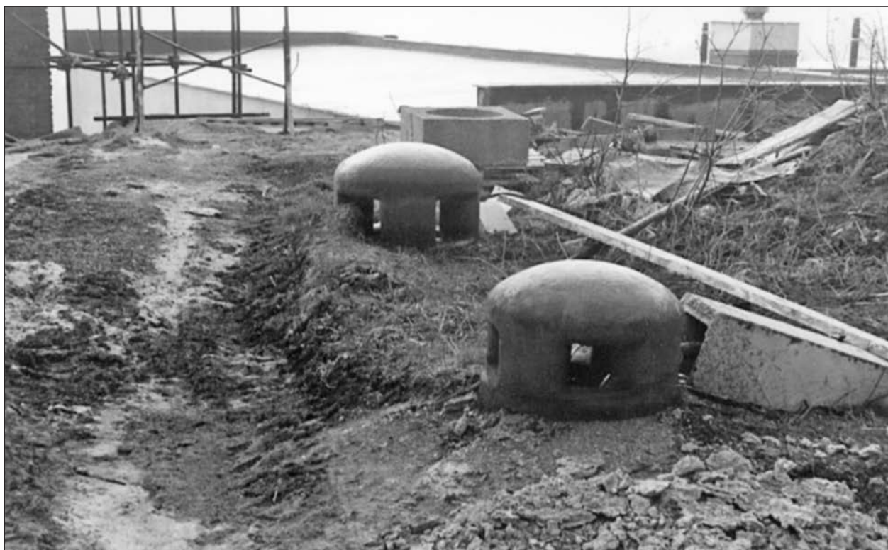
Pohled na oba evakuační zvony (vpředu střední, vzadu velký typ) vchodového objektu R-H-S 79a tvrže Hanička v době budování přístavby před objektem v rámci akce KAHAN v 80. letech (JF).
