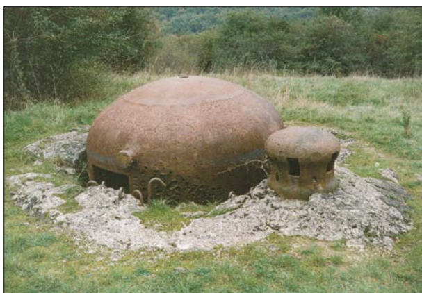
Ventilační zvon "přilepený" ke zvonu GFM. (LČ)
