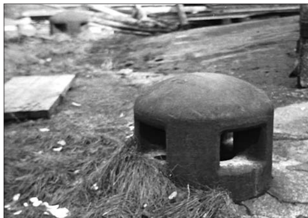
V roce 1986 byly ještě oba ventilační zvony na objektu R-S 78 na svém místě. (1986, TS)
