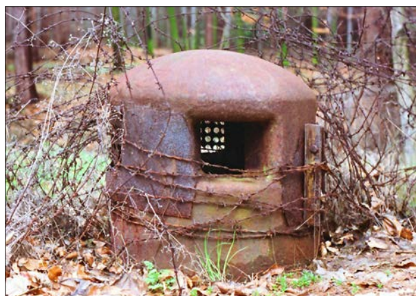
Ventilační zvon na objektu MO-S 38 na tvrzi Smolkov byl v poválečném období ovinut plechem s průduchy a omotán ostnatým drátem. (TS)
