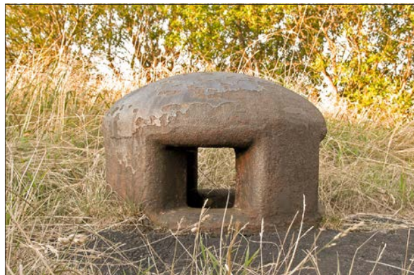
Stejný ventilační zvon jako na vedlejší fotografii, ale o šedesát pět let později. Na rozdíl od obou pancéřových zvonů zůstal na svém místě dodnes. (2003, LČ)
