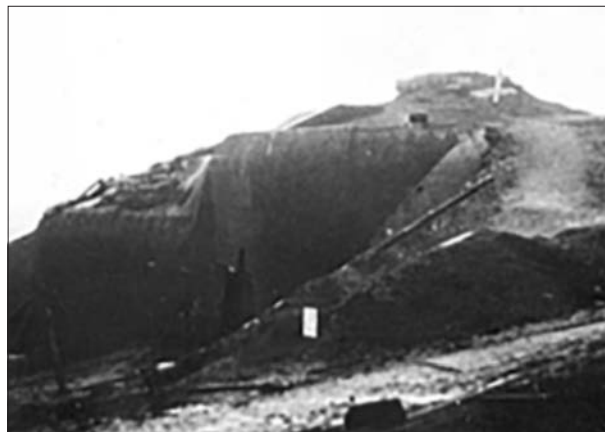
Nekvalitní fotografie pěchotního srubu K-S 41 tvrže Adam s rozeznatelným nasávacím ventilačním zvonem. (eBay)
