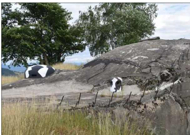
Pohled na stejný objekt o devět desetiletí později – chybějící ventilační zvon nahradila betonová maketa.
