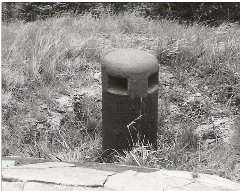
Unikátní fotografie ventilačního zvonu malého typu na střeše pěchotního srubu K-S 23 tvrže Bouda v roce 1961, kdy byl zvon ještě stále na svém místě (foto Josef Durčák, sbírka MP). Vpravo jsou zbytky ocelového potrubí, které na místě zbyly dodnes. (LČ, MP)
