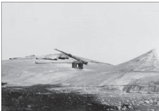
Jediná známá fotografie ventilačního zvonu (evakuačního) objektu K-S 22 tvrže Bouda. (LT)
