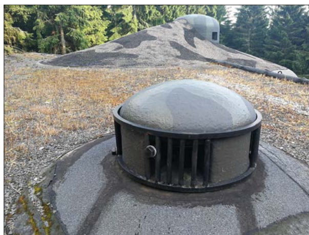
Detail repliky ochranné mříže vyrobené podle výkresu R 318 na objektech R-S 76 a 78 tvrže Hanička. (2019, 2023, LČ)
