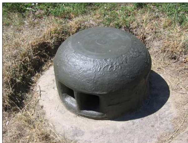
Zachovalý ventilační zvon typu 715P2 na objektu Pz.W. 716 tvrže Scharnhorst, MRU Polsko. (PS)
