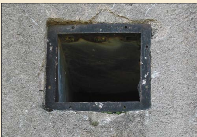
Otvor pro nasávání vzduchu ve stěně pěchotního sruhu N-S 73 tvrže Dobrošov byl naopak ve výšce téměř tří metrů nad terénem – vlevo detail oplechování vnější části sacího kanálu, vpravo pohled na umístění otvoru na dobové fotografii objektu N-S 73. (2003, LČ)
