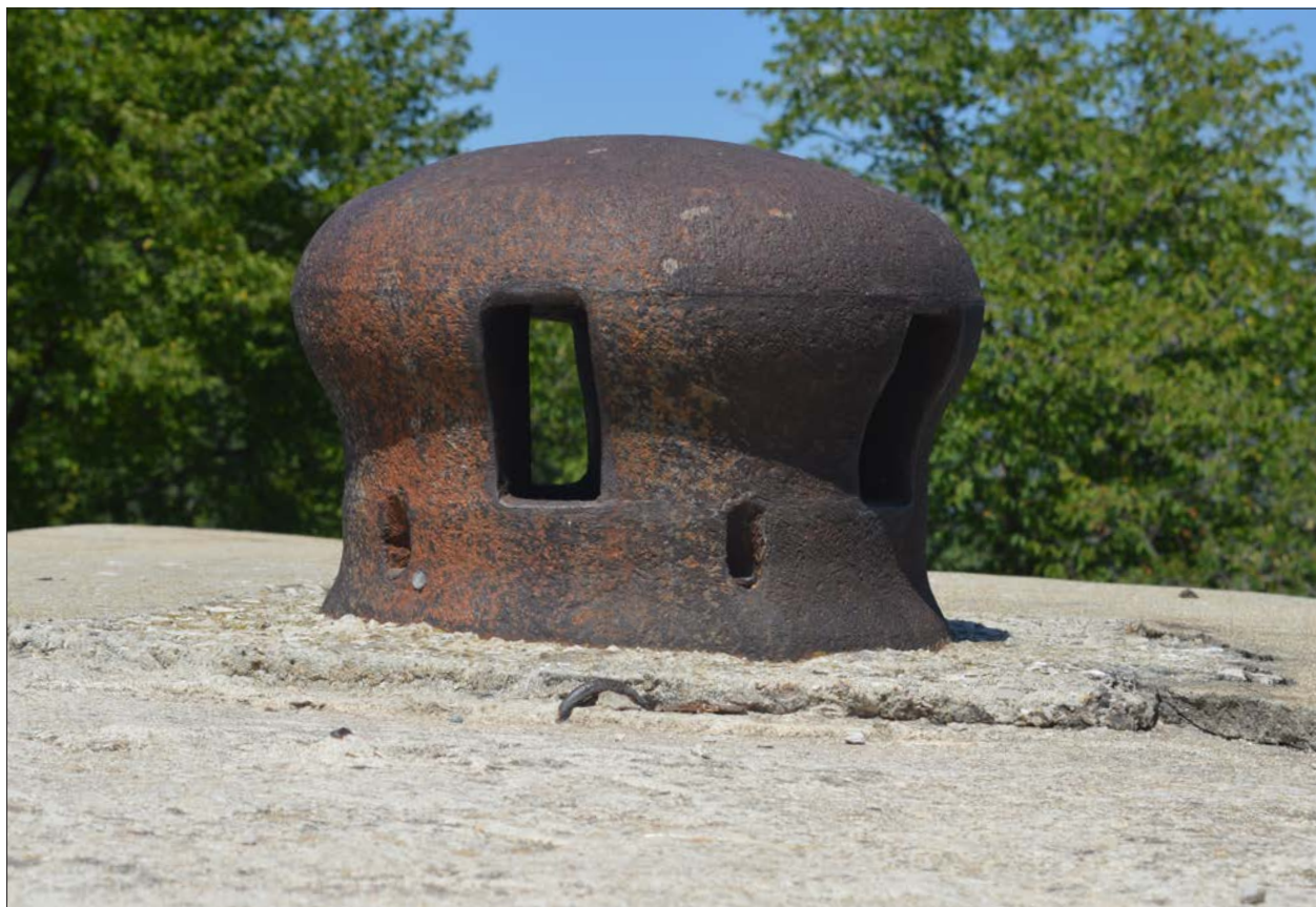
Ventilační zvon na objektu B2 pozorovatelný Pic de Garuche v alpské části Maginotovy linie. Dobře jsou vidět otvory pro nalití roztaveného olova pro svaření zvonu a potrubí. (2021, MP)
