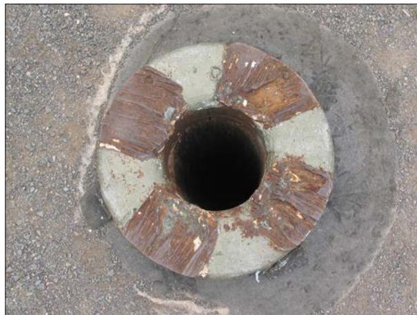
Pohled zhora na ventilační zvon objektu R-S 78 s uříznutým vrchlíkem. Velmi dobře je vidět pravidelné rozmístění trychtýřovitých otvorů pro přístup vzduchu do potrubí. (2003, LČ)
