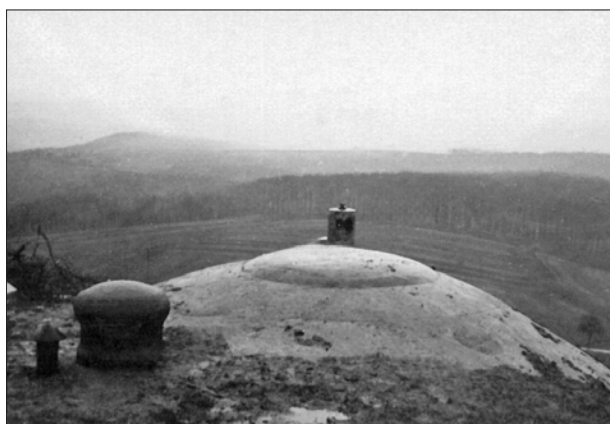
Ventilační zvon vedle pozorovacího zvonu. (1940, eBay)
