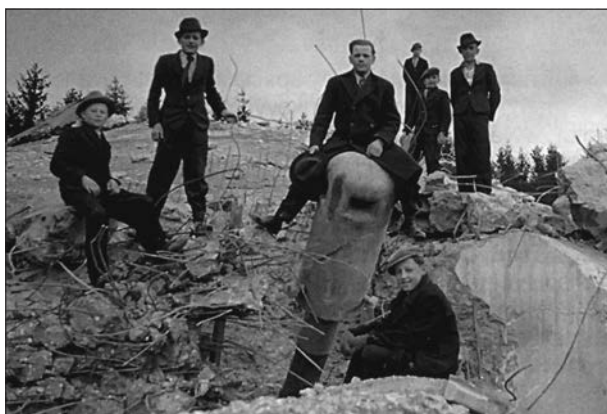
Vytržený ventilační zvon včetně potrubí na pozorovatelně MO-S 42 tvrže Smolkov. (Opevnění IV. sboru, 3. část)
