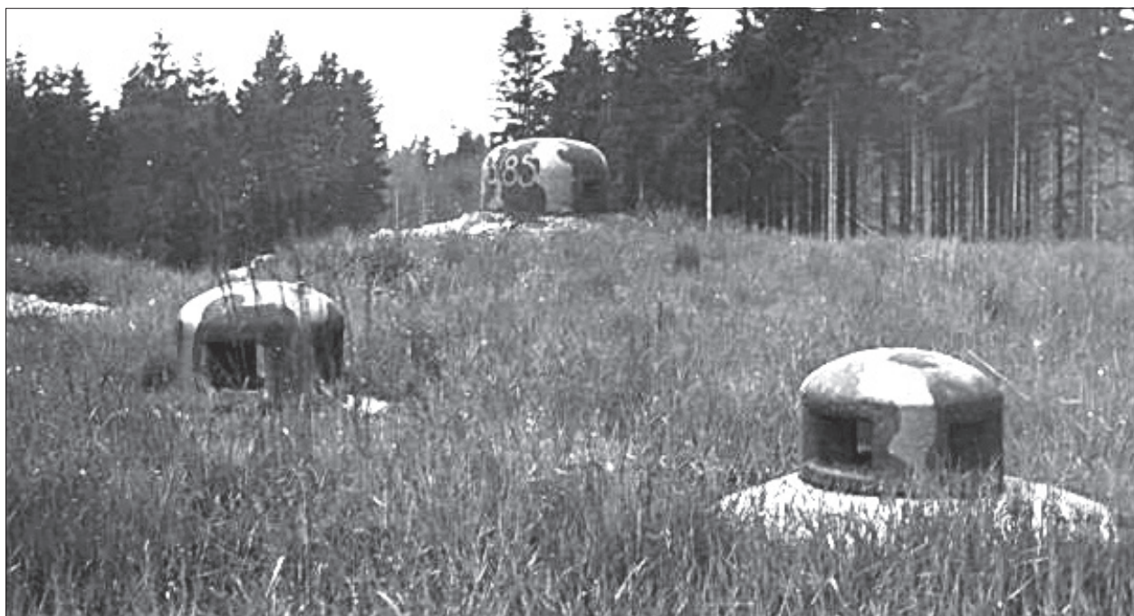
Zarostlá střecha vchodového objektu R-S 79a tvrže Hanička v období války. Na obou ventilačních zvonech (vlevo velký, vpravo střední typ) i na pěchotním zvonu (s německým evidenčním číslem) je dobře vidět původní maskovací nátěr. (eBay)
