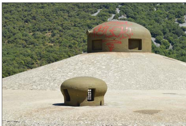
Ventilační zvon objektu B3 malé tvrže Col des Banquettes v Přímořských Alpách. (2014, MP)
