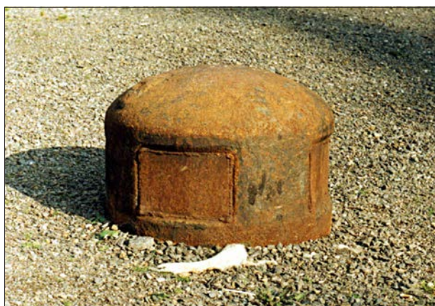
Evakuační zvon objektu R-S 78 se zavařenými otvory. Tato úprava byla provedena při přestavbě objektu při akci „KAHAN“. (1998, LČ)
